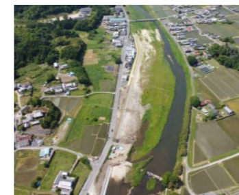
木津川河川改修(築堤護岸)工事
