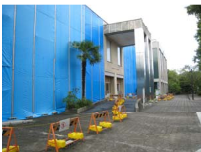
2007年9月19日撮影。タイル崩落防止のためシートで覆われています。現在閉館中。
